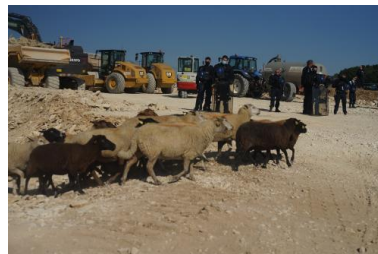
Les pelleuses font demi-tour sur le chantier à l'arrivée des manifestants © Amélie Poinssot / Mediapart
