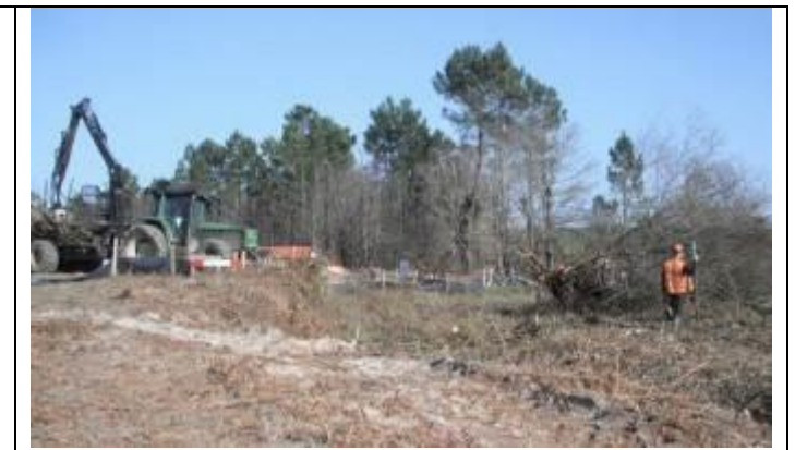
Abattage manuelle en zone humide avec mare, puis câblage des bois depuis l'extérieur de la zone à risque (C.Bout – GREGE).
