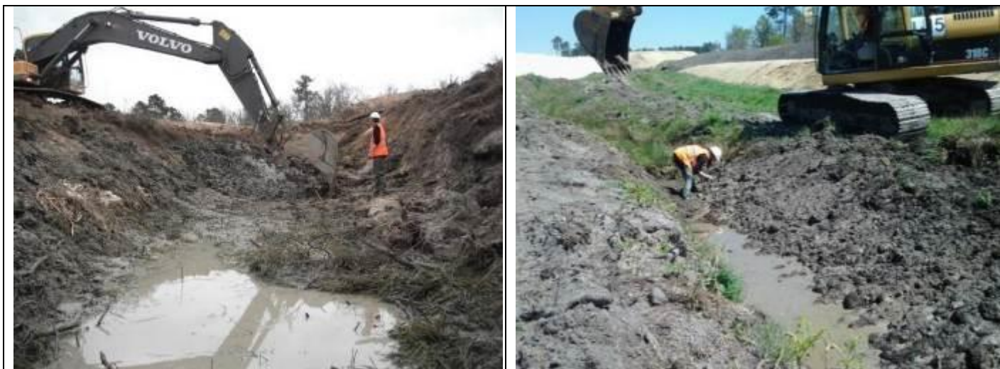
Curage d'une mare au godet après vidange et griffage des berges (C.Bout – GREGE).
