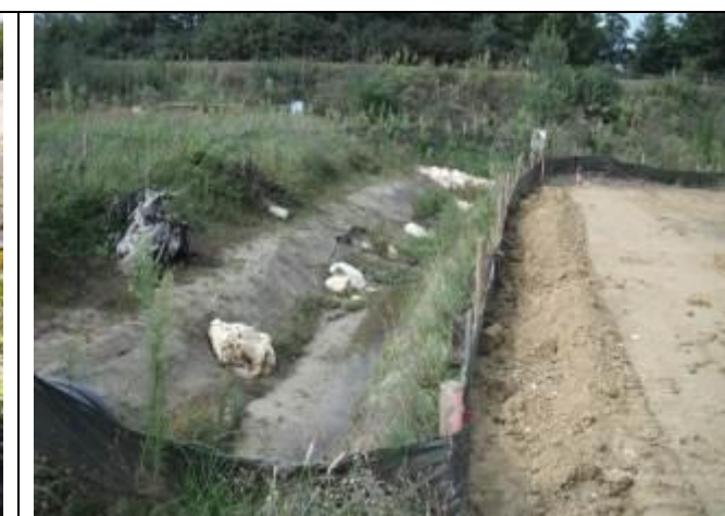
Dérivation artificielle avec une risberme, des souches, des blocs, s'étant végétalisée dans un second temps (C.Bout – GREGE).
