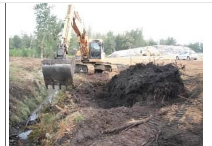
Dessouchage d'une souche de chêne à l'aide d'une pelle mécanique à godet à dents (C.Bout – GREGE).
