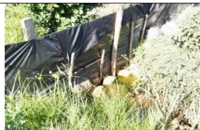
Clôture de mise en défens bien étanche au niveau du sol (P.Fournier – GREGE).
