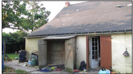
Façade nord de l'habitation (arrière)
