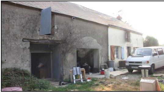
Façade sud de l'habitation (entrée), débarras et dépendance pour chiens (à gauche)
