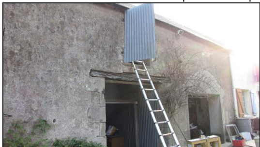
Visite des combles au-dessus des boxes
