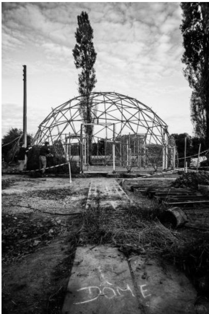
Construction d'un dôme/salle de réunion lors du weekend "Refaire un dôme" les 25 et 26 Juin 2016
