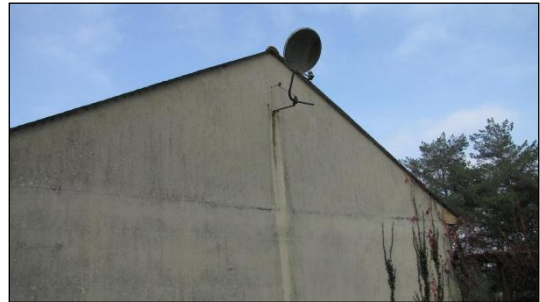
Côté du bâti
