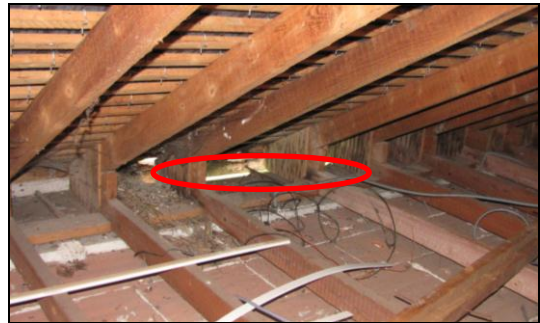
Grenier : existence d'un accès
