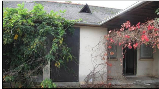
Bâti côté entrée
