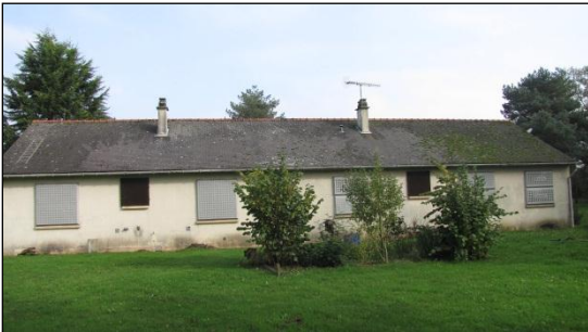
Arrière du bâti
