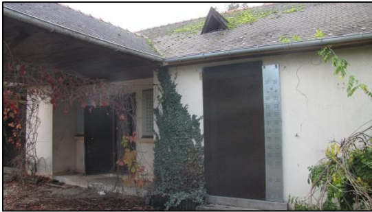
Bâti côté entrée
